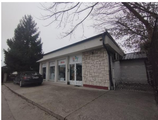
Ф.1. Поглед на постојећи пословни објект који егзистира на предметној локацији - поглед са југоисточне стране
