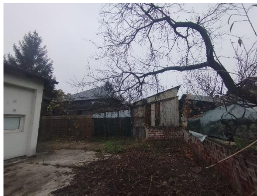
Ф.4. Двориште иза постојећег објекта који егзистира на предметној локацији
